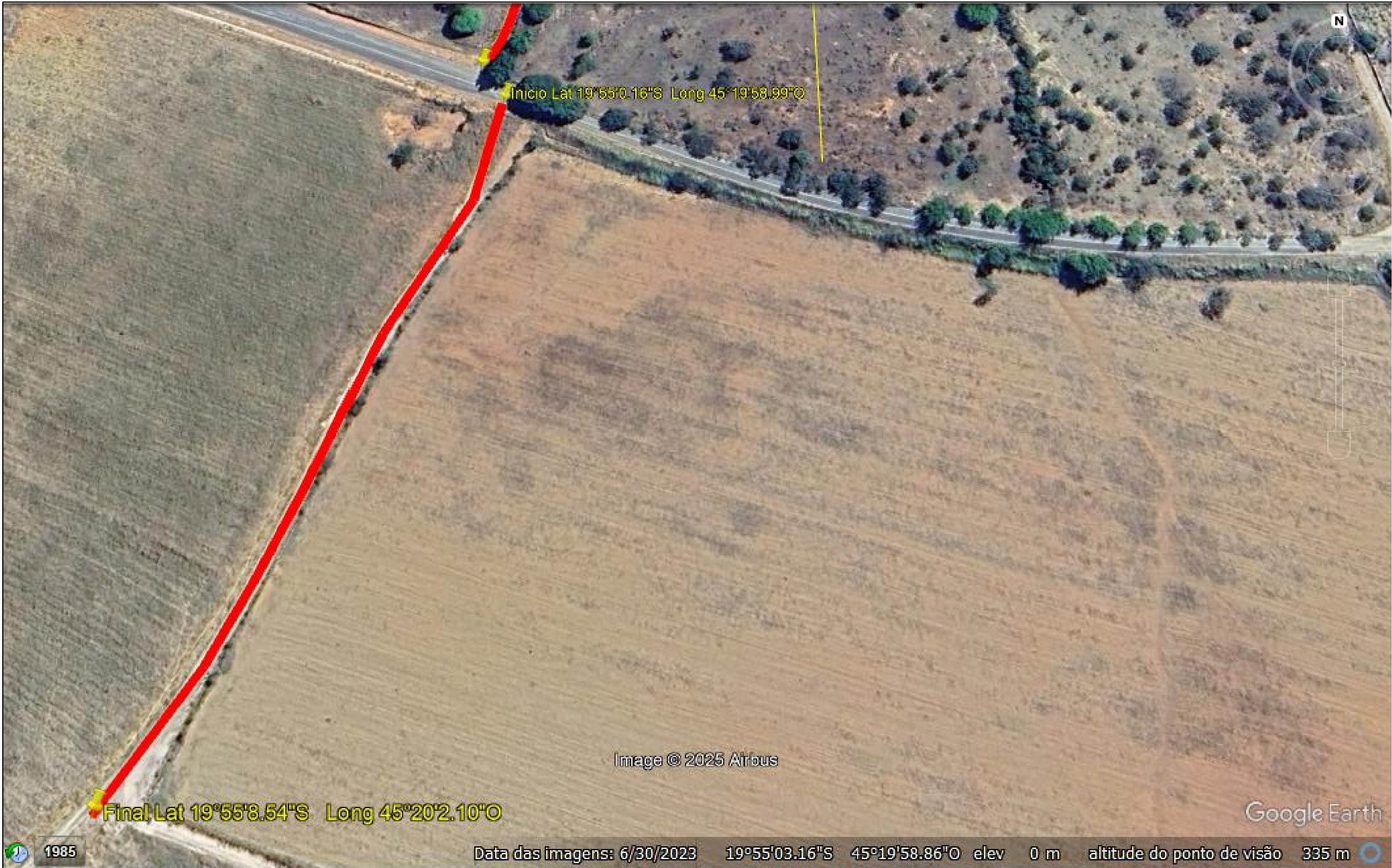
ESTRADA VICINAL DE ACESSO AO CEMITÉRIO (CHAPADA) - PAVIMENTAÇÃO EM C.B.U.Q Comprimento: 274 m
