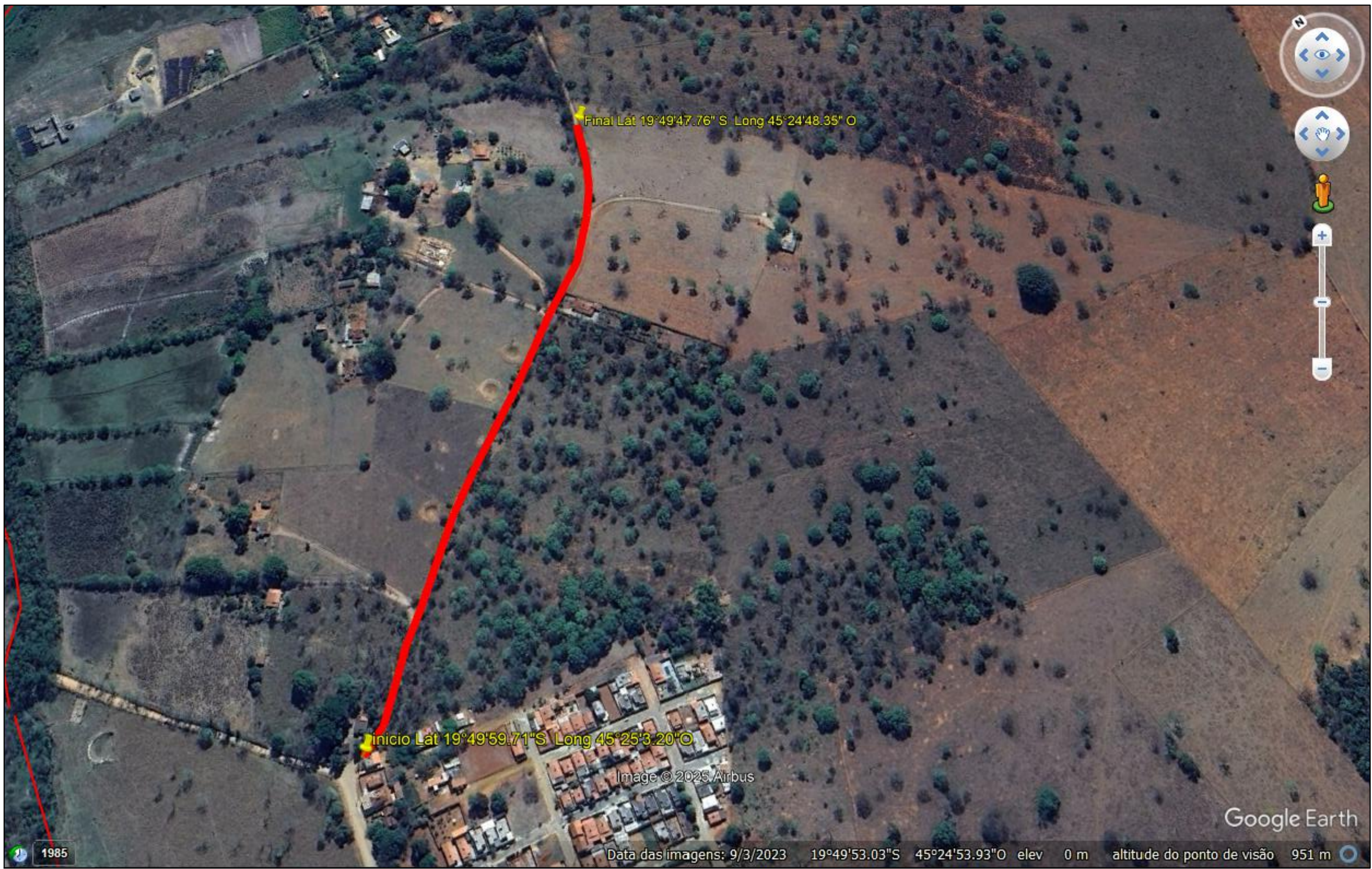
ESTRADA VICINAL ZÉ BRASIL - PAVIMENTAÇÃO EM C.B.U.Q Comprimento: 620m
