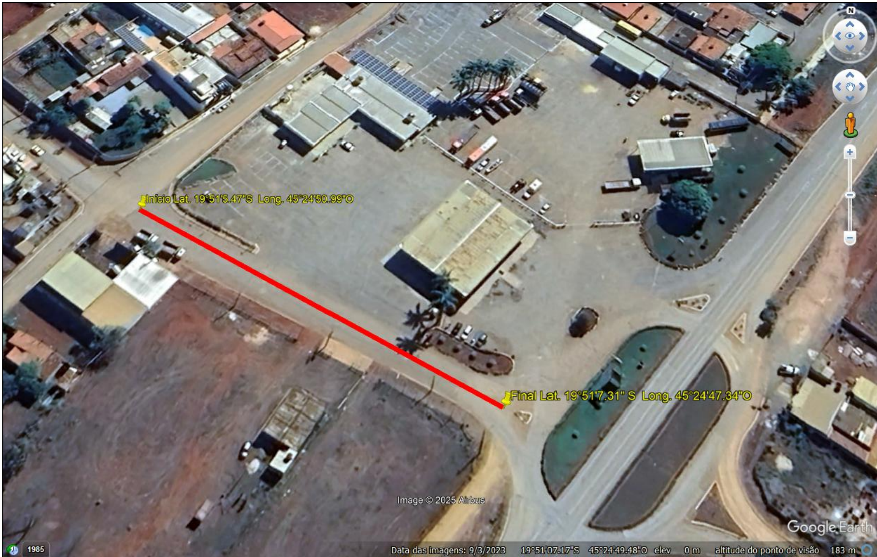
RODOVIA BH-ARAXÁ - BAIRRO PROGRESSO ( MUNICÍPIO DE MOEMA/MG) - RECAPEAMENTO EM C.B.U.Q Comprimento: 114 m
