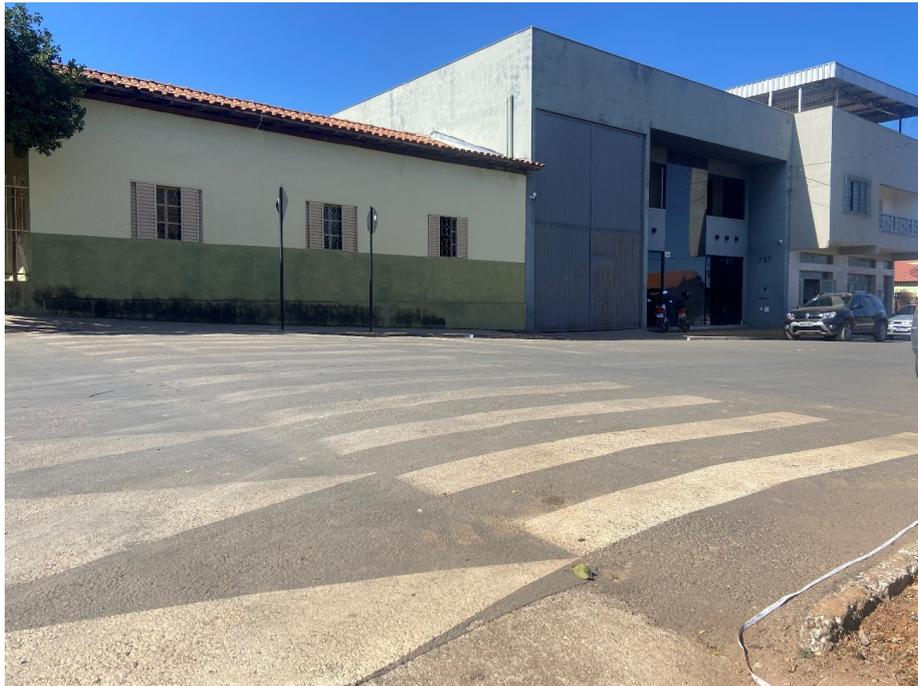
**Exemplo 3 – Faixa Elevada com medida de 3,80m X 0,10m (exemplo para comparação de uma Ondulação Transversal do TIPO A)**
