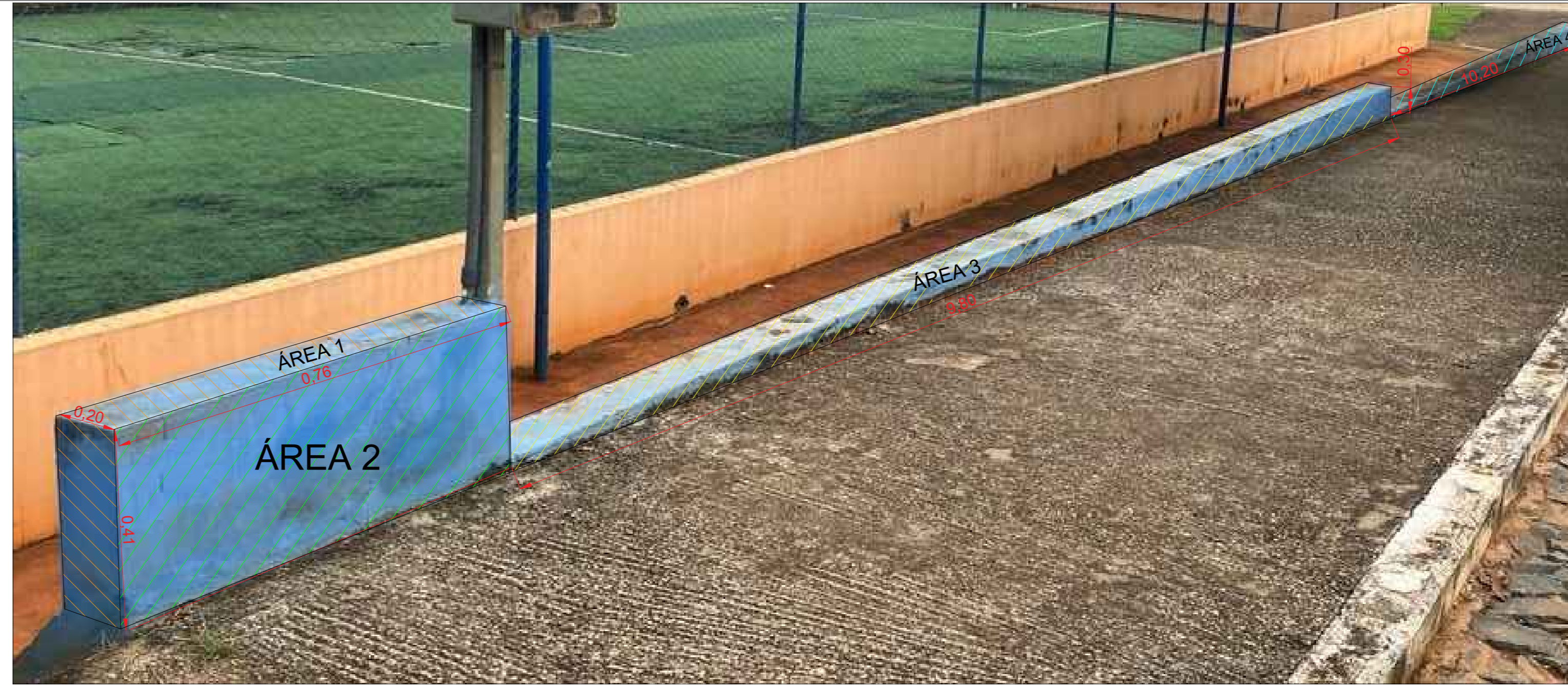
PERSPECTIVA – DISPOSIÇÃO TÍPICA DAS JUNTAS SEM ESCALA
